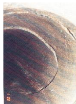
scheuren in de rioolbuis waardoor deze mogelijk kan instorten
