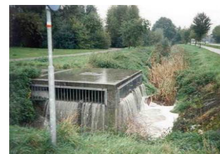
uitworp via overstorten leidt niet tot stank en vervuiling
