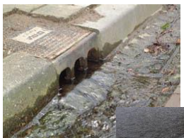
water stroomt goed af via kolken door structurele reiniging
