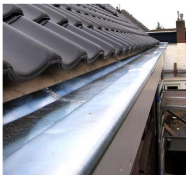
er worden uitlogende materialen toegepast
