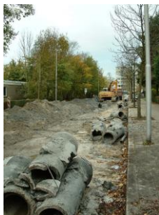
slechte riolen worden tijdig vervangen
