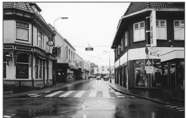
... en na de verbouwing in de jaren 70
