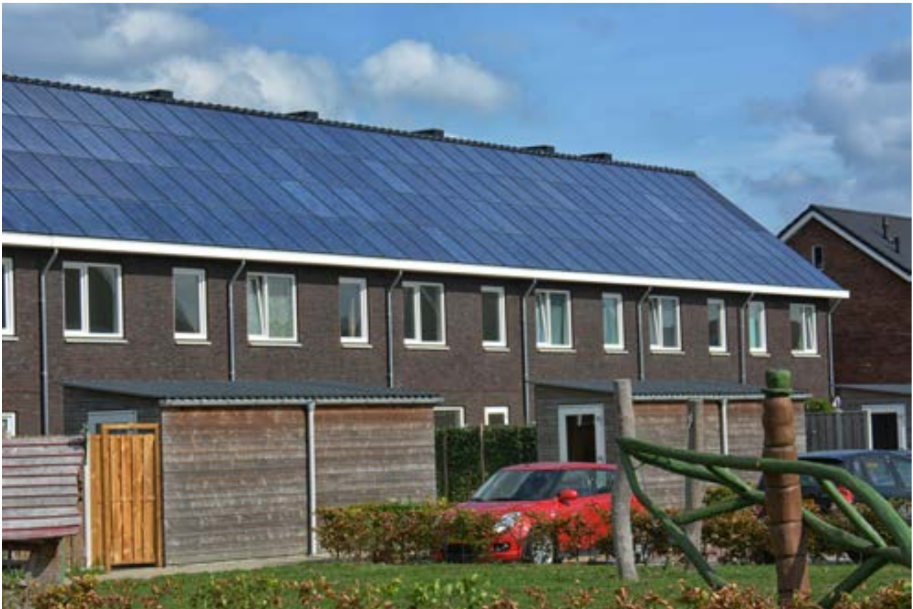
Energieneutrale woningen van het MorgenWonen-concept in Holten
